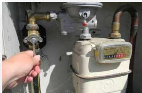
Photo 14A2 : Coupure du gaz au niveau d'un compteur
