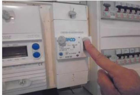
Photo 14A3 : Coupure de l'électricité au niveau d'un compteur
